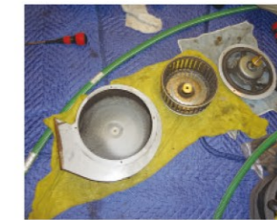
レンジフード分解清掃
