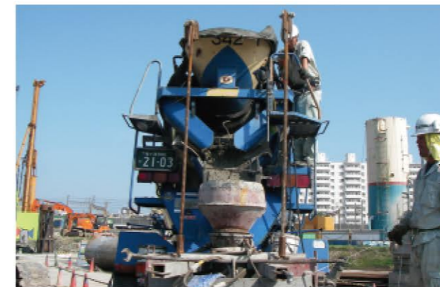
杭コンクリート打設
