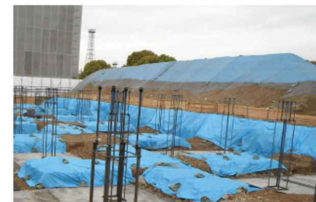
場内の土砂置き
